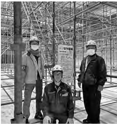
体育館のメンテナンス改修現場をチェック
