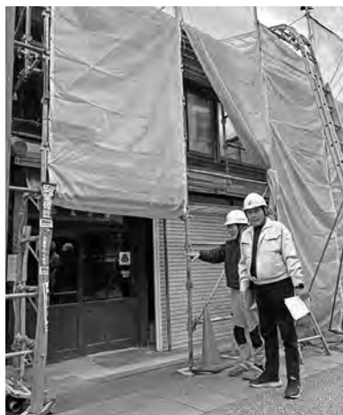
足場設置状況を安全チェック
