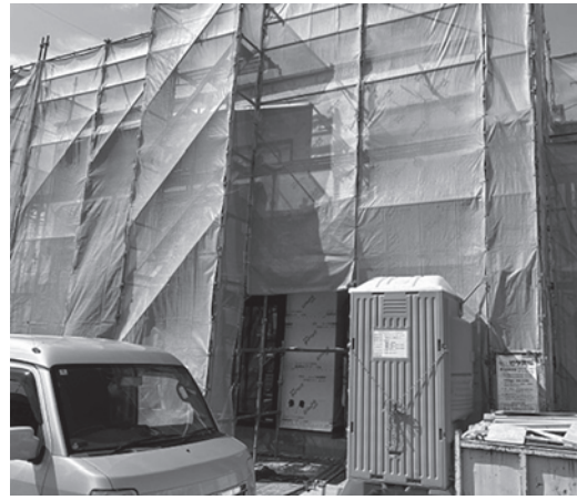
足場設置や労働衛生面などを確認
